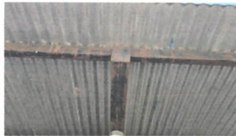
Foto 2: ESTRUCTURA DE TECHO
