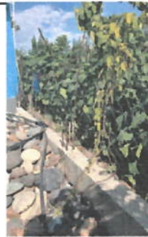
Foto 4: CERCO O MURO PERIMETRAL
